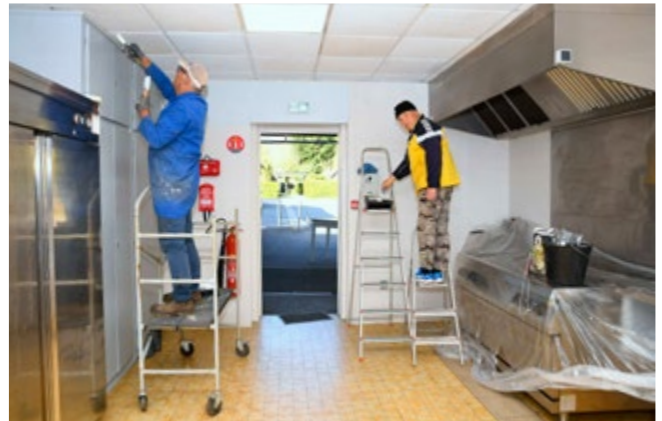
Une cure de jouvence pour le plafond et les murs de la cuisine.
