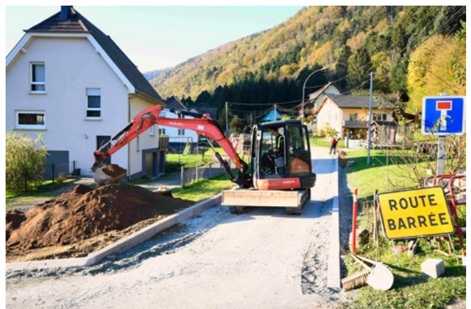
Rénovation de voirie rue Foerstel : Mise en place de bordures et revêtement de la chaussée. Montant des travaux : 53 285,03 € TTC Subvention CEA : 25 755 € TTC
