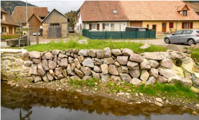
Rénovation des murs de soutènement de la Seebach (rue du ballon et du Foerstel). Travaux pilotés et financés par « Rivières de Haute Alsace »
