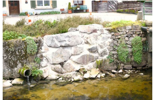
Rénovation des murs de soutènement de la Seebach (rue du ballon et du Foerstel). Travaux pilotés et financés par « Rivières de Haute Alsace »
