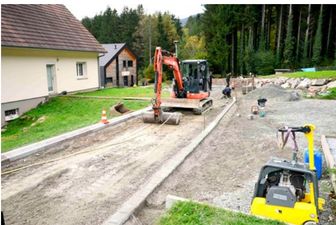
Rénovation de voirie rue Foerstel : Mise en place de bordures et revêtement de la chaussée. Montant des travaux : 53 285,03 € TTC Subvention CEA : 25 755 € TTC
